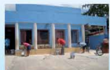
Pintura al local del DIF municipal
